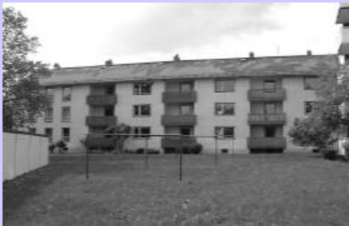
Alt: Wohngebäude vor der Modernisierung
