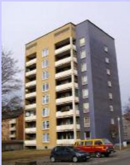
Sanierung des Wohnungsbestandes
