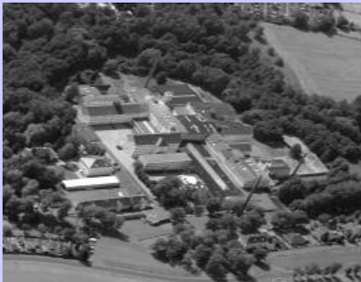
Alt: ehem. Porzellanfabrik - Gewerbebrache
